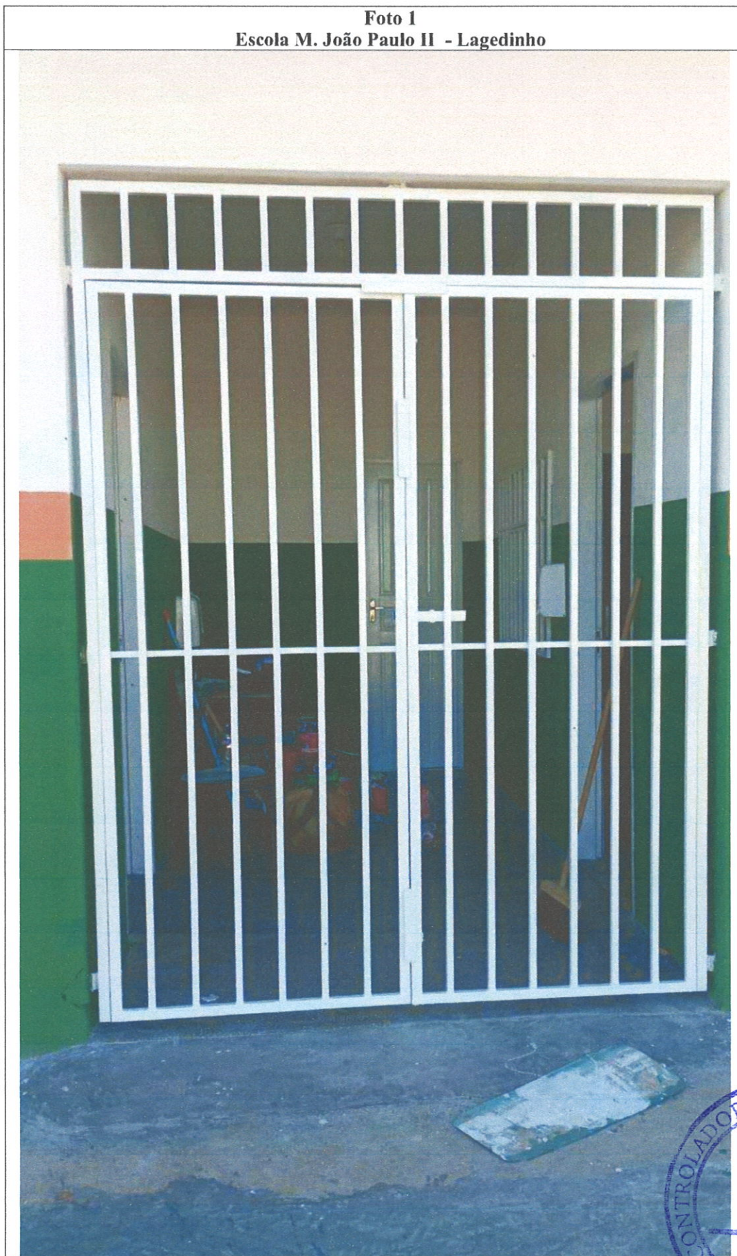
Execução de pintura em esmalte sintético em esquadrias metálicas.
