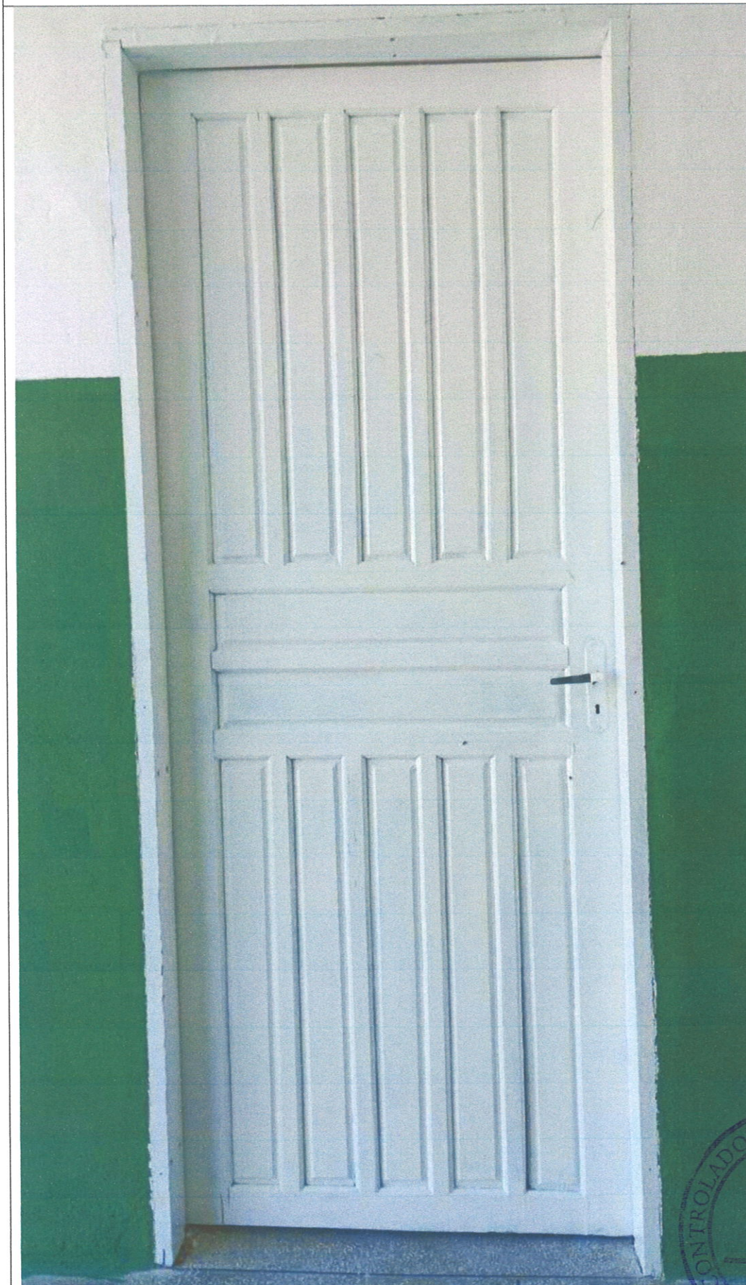
Execução de pintura em esmalte sintético sobre madeira.
