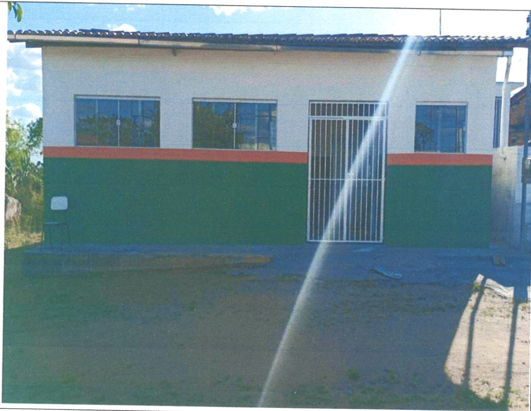
Execução de pintura latex.
